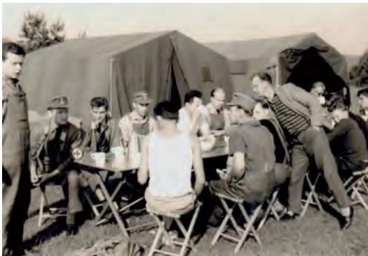
Kaffeepause, nachdem die Zelte und die Notstromversor- gung aufgebaut sind
