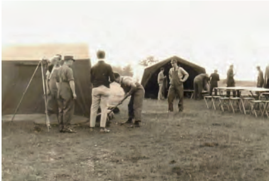
Aufbau der Zelte und der Notstromversorgung
